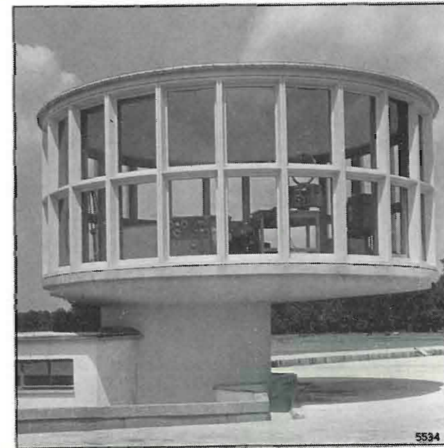
Fig. 2. — Torretta in legno, ove si effettuano le misure di campo elettromagnetico in OL, OM e OC, presso il Centro di Controllo di Monza.
